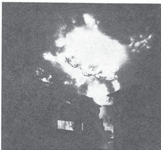
炎焼中の製造所(大阪市消防局提供)
