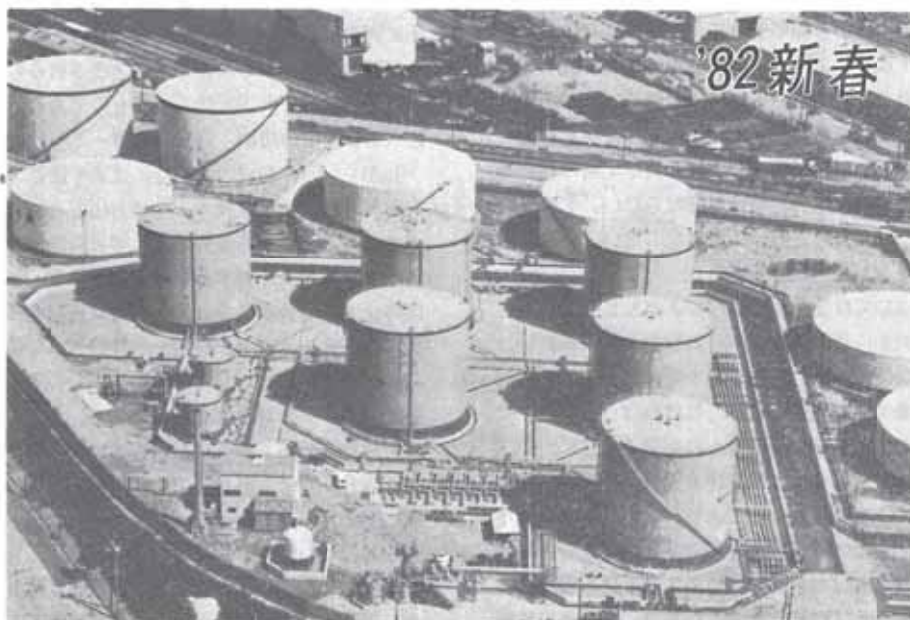
写真・新基準により建設された最新設備を誇る大阪・桜島埠頭槽タンク群
