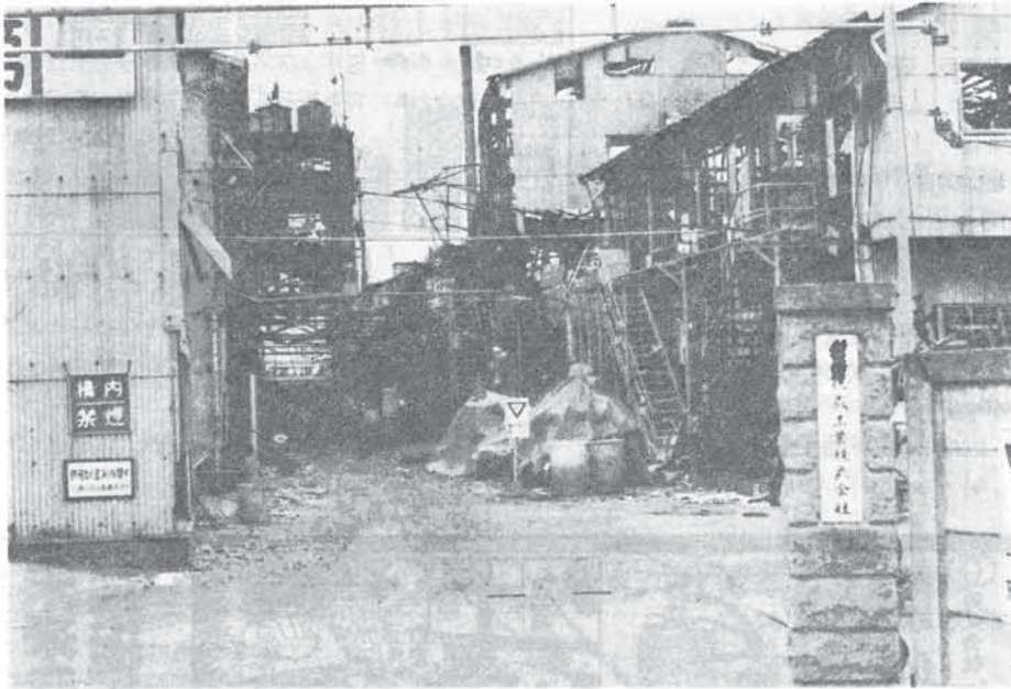
無残にも破壊された危険物工場と隣接試験室、事務所
