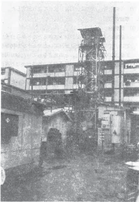
写真③ 蒸溜装置とボイラー室
