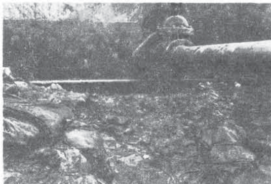
〔写真〕流出した原油で基礎が洗掘された。
