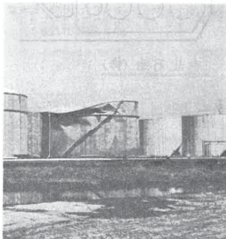
写真① 底板の破断により大量の軽油が一時に流出し、タンク内が減圧されて上部が損壊した。 No. 224 タンク
