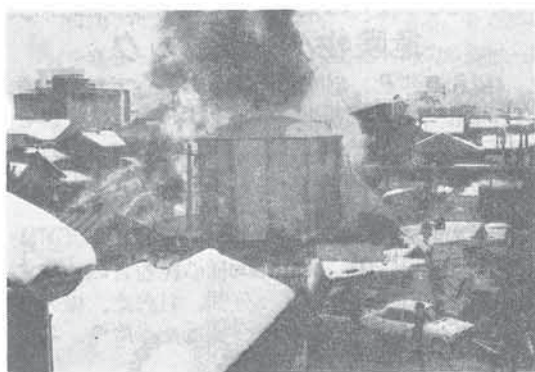
出火後約 8 分、ナフサタンクの真横で炎上
