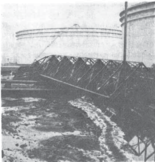
写真③ 倒壊したラダー
