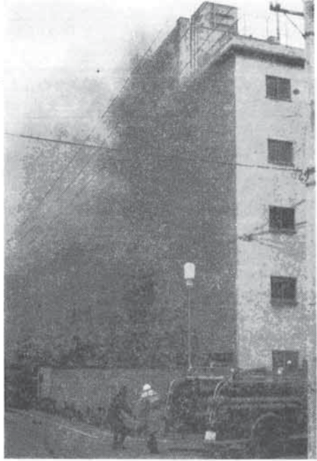
炎上する危険物一般取扱所
