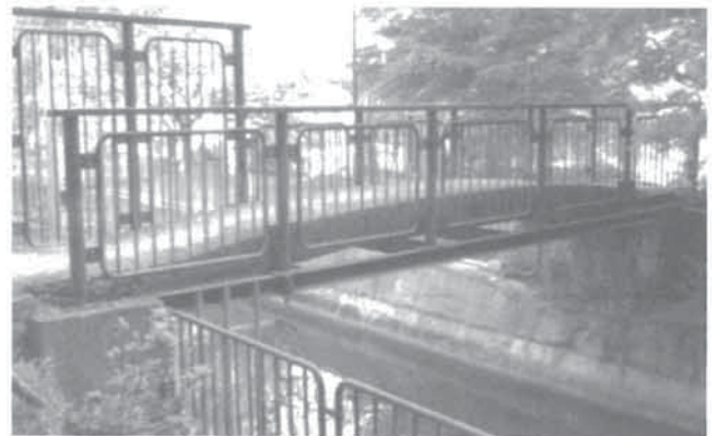
画像④ 琵琶湖第一疏水コンクリート橋(京都市山科区)
