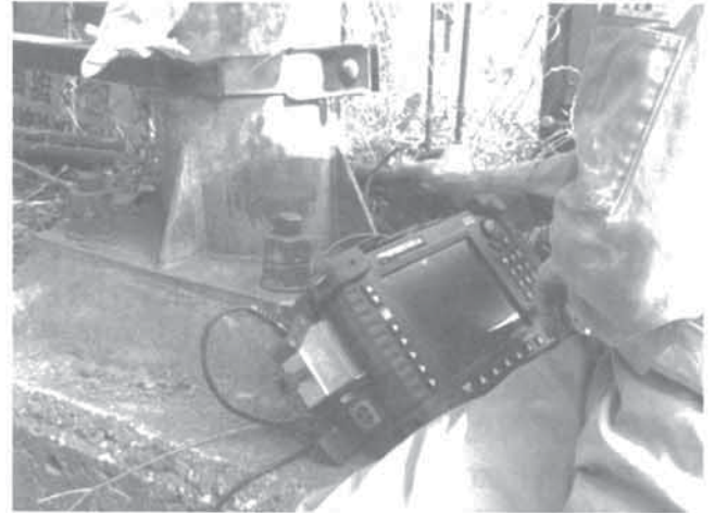
画像③ 超音波探傷試験(アンカーボルト)
