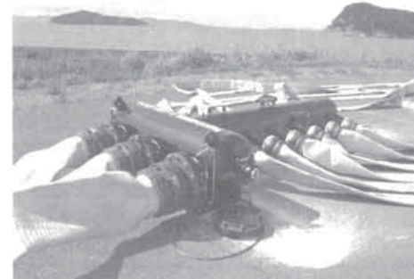
④ マニホールド： ホースを接続した状態
