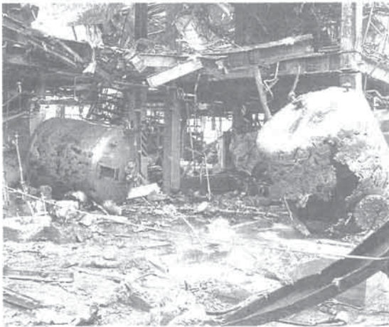
蒸留塔のあった場所を南より見る
