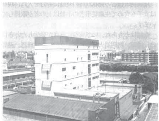
他建築物に取り囲まれている同社本社工場(中央部分)
