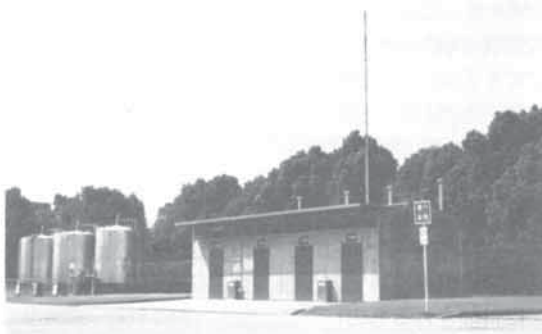
同工場敷地内の屋外タンクと屋内貯蔵所
