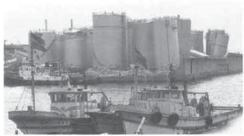
地震により傾むいたタンク群
