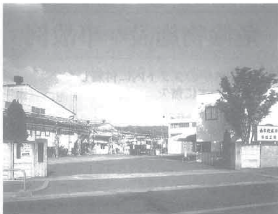
正門から見た山本化成機八尾工場
