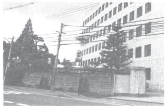
(株)西島製作所 事業所建物
