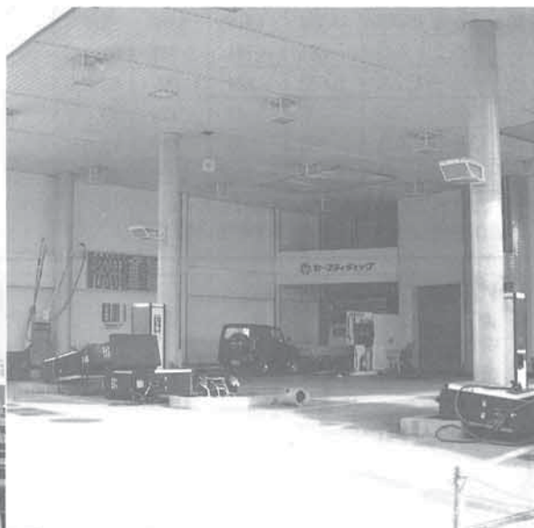
▲ スタンド式計量機のアンカーが破壊されて転倒。
