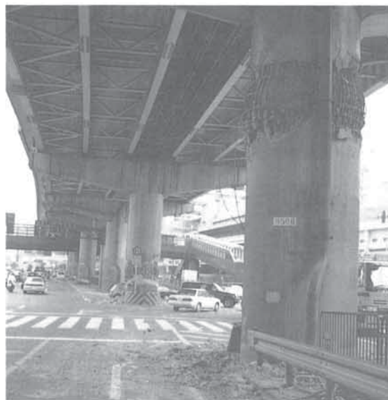
▲ 高速道路の架橋がはずれる。
