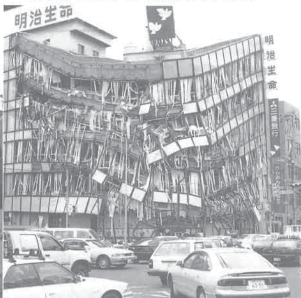
▲ 到壊寸前の鉄筋コンクリート造7階建ビル (大阪市消防局提供)
