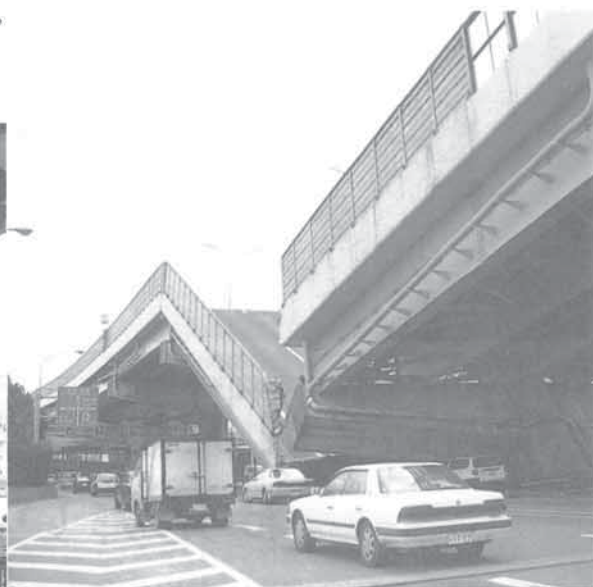
▲ 高速道路の架橋がはずれる。
