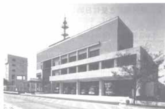
柏羽藤消防本部新庁舎
